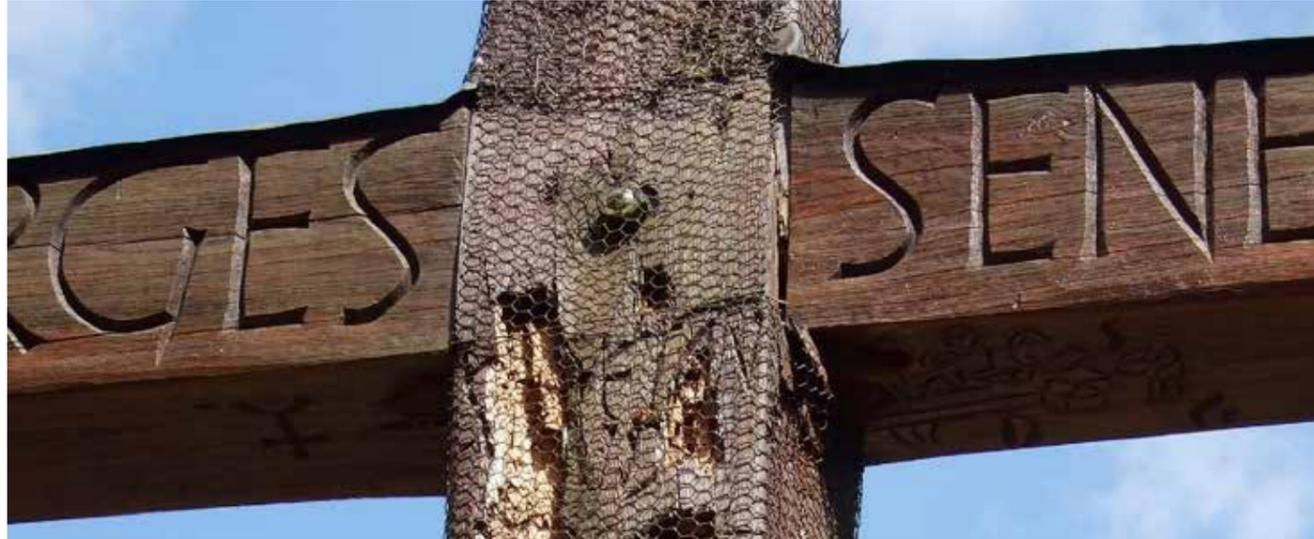
Kurz vor dem Abbau: Die Spuren der Verwitterung sind deutlich sichtbar
