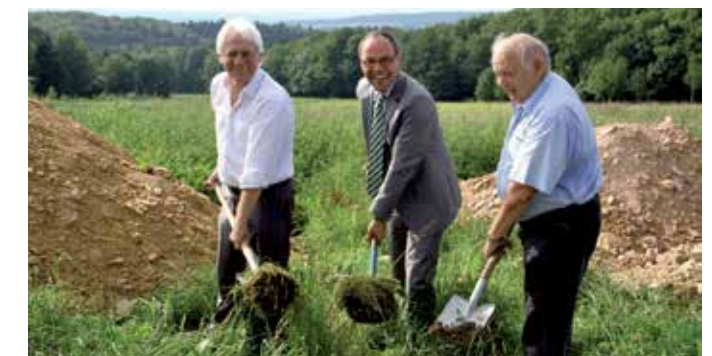
Meilenstein in der Vereinsgeschichte: Erster Spatenstich 2011
